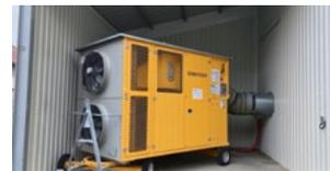
Groupe froid installé dans un local afin de limiter les nuisances sonores.
