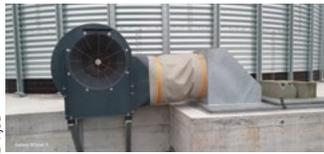
Ventilateur installé pour refroidir le grain avec de l'air ambiant.
